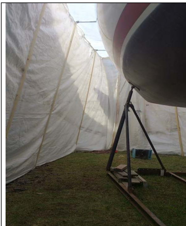
Bild 5. Utliggaren bör sticka ut minst 50 cm från relingen för att ge arbetsutrymme. En dubbel presenning hängs från utliggaren som vägg och hålls mot backen från utsidan med stenar eller dylikt. Båten täcks från ovasidan med en presenning.
