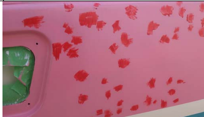
Bild 15. ....nej, det var inget skämt. Provade dock först att lägga på grundskikt #2 (utblandad med 0,5 dl. topplack för att få en kontrast mot det vita fribordet) och det var bara att konstatera att det hjälpte inte med ett skikt till. Så, slipa grundskikt #2, spackla alla hål, slipa ned spacket, måla grundskikt #3 (skulle egentligen inte behövs, två grundskikt är tillfyllest), slipa grundskikt #3. Fy f..n vilket merjobb! Men resultatet blev perfekt. Ytan var nu lika len som en flickstjärt och av mikrohålen syntes ingenting. Till saken hör att den nedre randen saknade problemen med mikrohål, så den målades endast två gånger.
